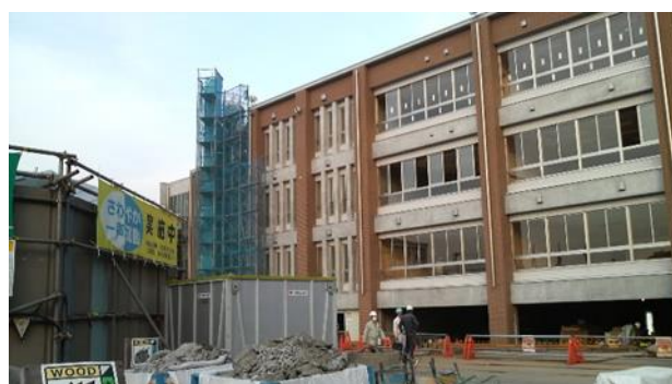
新校舎建設(平成20年～平成23年)
